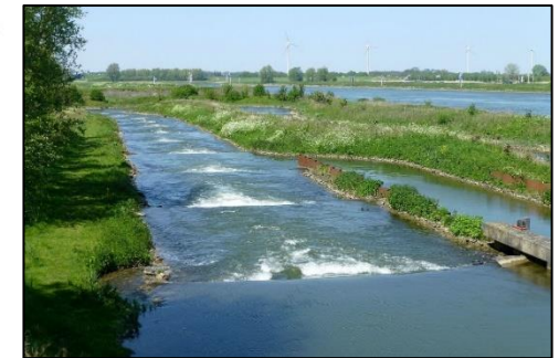
Vistrap bij het sluis- en stuwcomplex bij Hagestein, Driel en Amerongen
