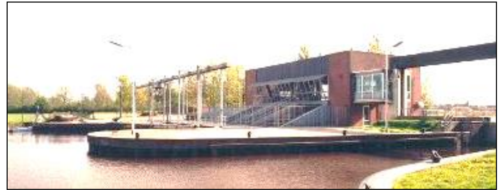
H.D. Louwesgemaal in het Hunsingokanaal bij Zoutkamp Ter ondersteuning bemaling door gemaal De Waterwolf (Reitdiep) Rechts van het gemaal een keersluis
