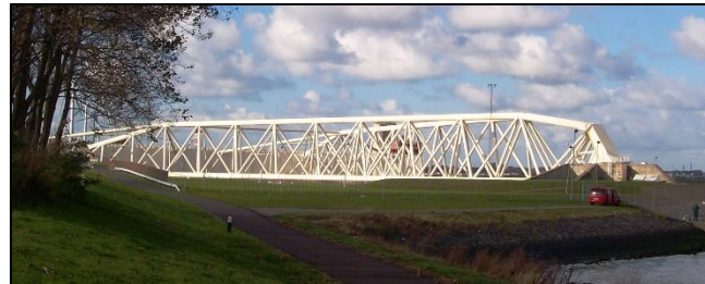
Constructie waterkering
