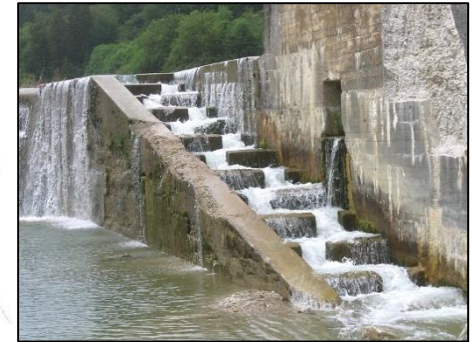
Vistrap naast een stuw of waterval
