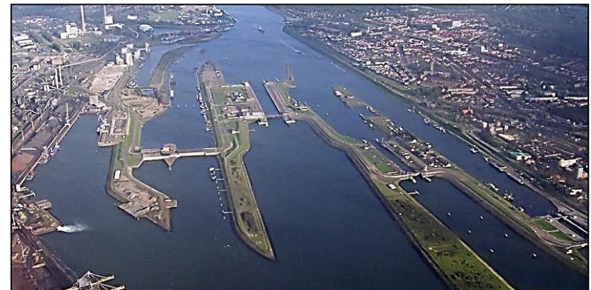
Sluizencomplex van IJmuiden Zuidersluis - Middensluis - Noordersluis - Spuisluis - Gemaal
