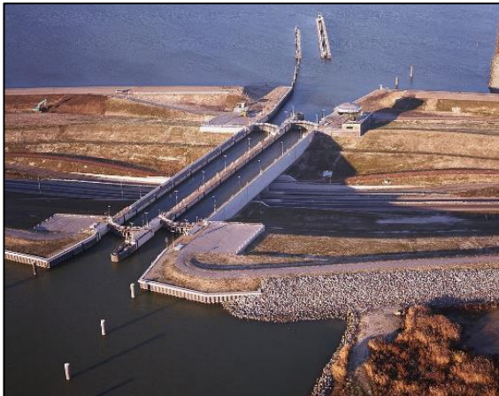
Naviduct (aquaduct met sluis)
