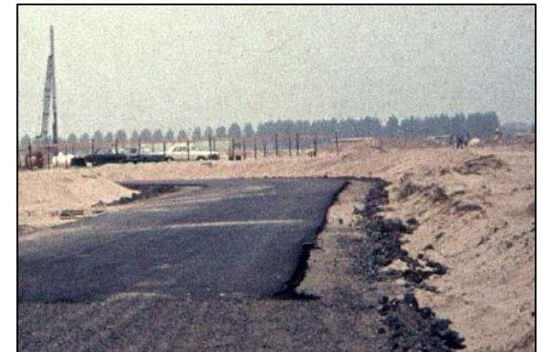
Bouwwegen en noodstraten
