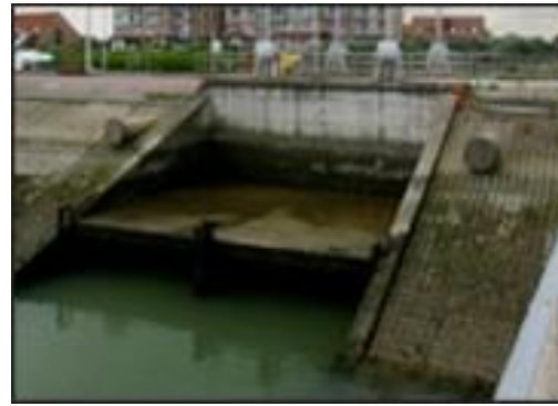
Spui- en keersluis met schuiven
