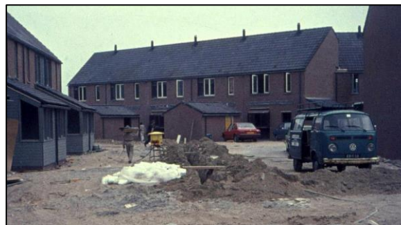
Kabels en leidingen
