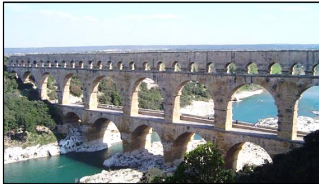
Beroemde Pont du Gard bij Nîmes in Frankrijk Bouwtijd 38-52 Hoogte 49 m Lengte 50 km Capaciteit 50.000 m 3 per dag; verval 24 cm per km Voor badhuizen, bronnen en fonteinen
