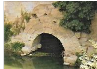
625 v. Chr. Open riool 60 v. Chr. Overkluizing riool (beide foto's)
